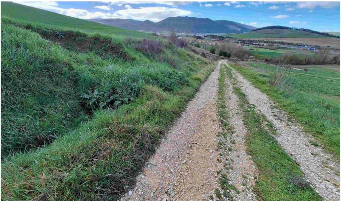
Deslizamiento de espueda sobre cuneta
